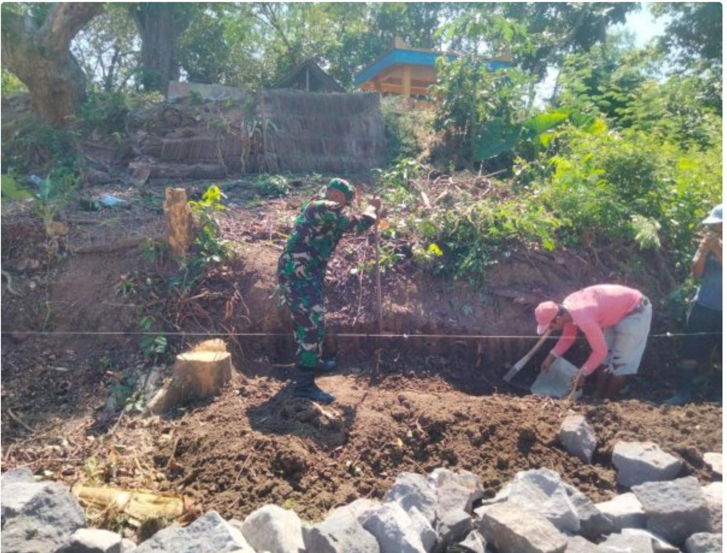
Babinsa Desa Duwet Karya Bakti Pembangunan Talud Di TPU Kyai Klungsu
