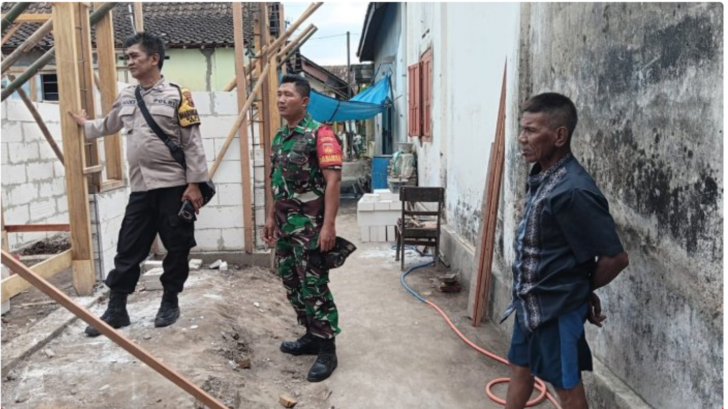
Pembangunan RTLH Desa Binaan, Ini Kata Babinsa Ceper
